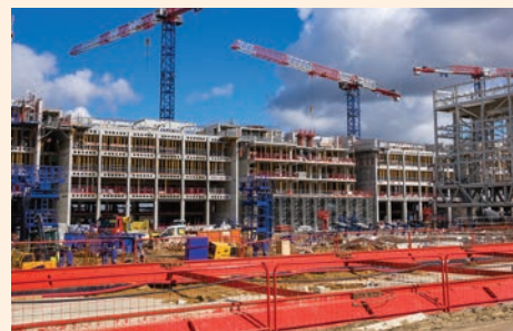
Figure 3.9 - L'ENS de Paris-Saclay en chantier. En façade, des vantaux régulent la ventilation naturelle de la plus grande partie de cet ouvrage (Renzo Piano Architecte).
