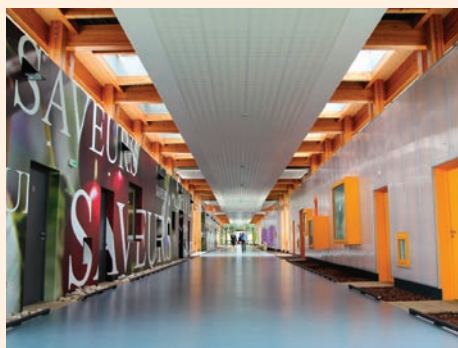
Figure 3.2 - Les lanterneaux sont un classique des équipements de toitures industrielles et tertiaires.
