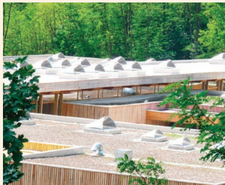
Figure 3.4 - Apports lumineux par puits de lumière sur le toit.
