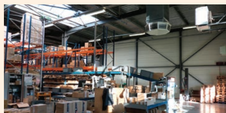
Figure 3.6 - Les systèmes de ventilation adiabatique assure une ventilation permanente efficace et une fonction de rafraîchissement à très faible coût global.
