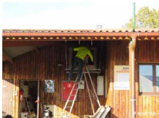
Après étude de la part de Gérard Gaget, c'est en 2018 qu'une solution adiabatique a été installée afin de rafraîchir la salle de rencontre. Il s'agit d'un modèle Adiabox WFP 8 000 m3/h avec soufflage vers le côté. En raison de son encombrement (et à défaut d'être en toiture), l'appareil est maintenu mécaniquement à l'extérieur du bâtiment. Un conduit relie
