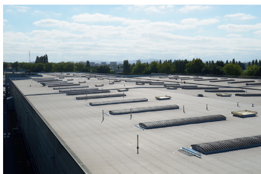
Anciens lanterneaux filants remplissage polyester avant rénovation
