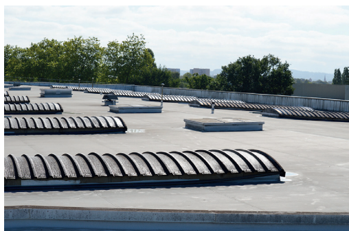
Anciens lanterneaux filants remplissage polyester avant rénovation
