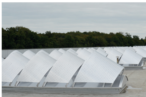
Voûtes filantes remplissage PCA avec brise-soleils après rénovation
